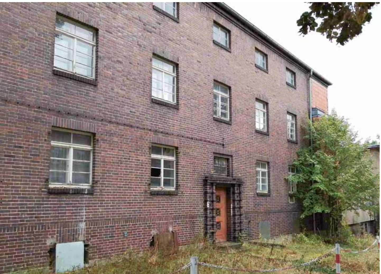
Eingangssituation im Gebäudeteil Wohnen
